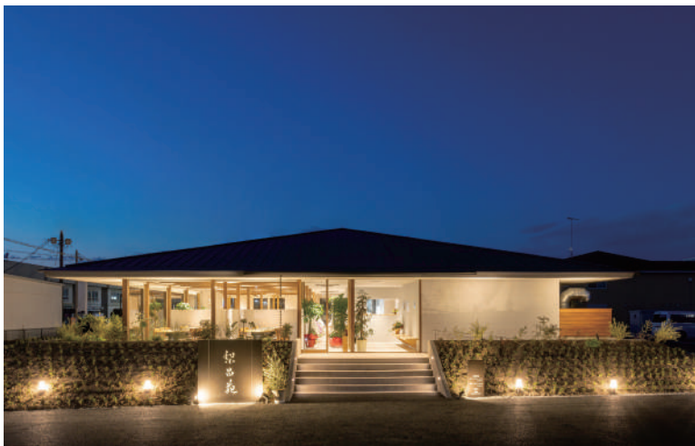
有限会社梨昌苑新築工事 構造：木造1階 / 延床面積(m 2 ): 291.42
