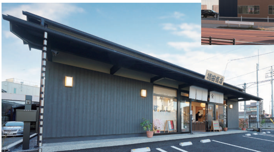
店舗新築工事 構造：木造平屋建 延床面積(m 2 )：81.15
