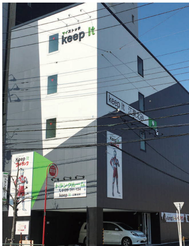
トランクルーム新築工事 構造：S造 5階建 延床面積(㎡)：731.02
