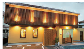
店舗改修工事 構造：S造 延床面積(㎡)：122.73
