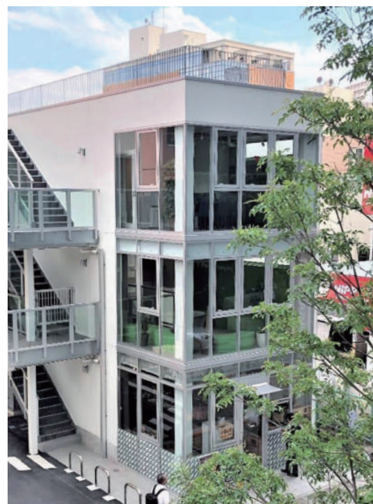
テナントビル新築工事 構造：S造 / 延床面積(m 2 ): 510.27
